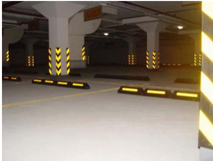
Protector de columna Altura Efectiva de 800 mms. Medidas de 100 X 12 mms
